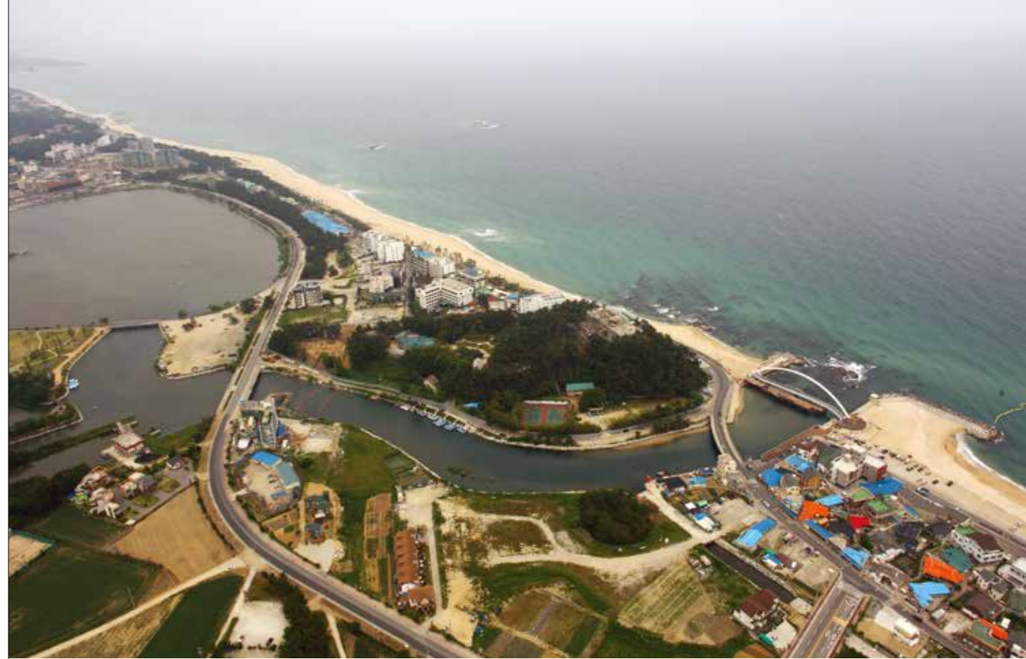
写真5 江陵・江門洞土城の遠景(砂丘に位置)
