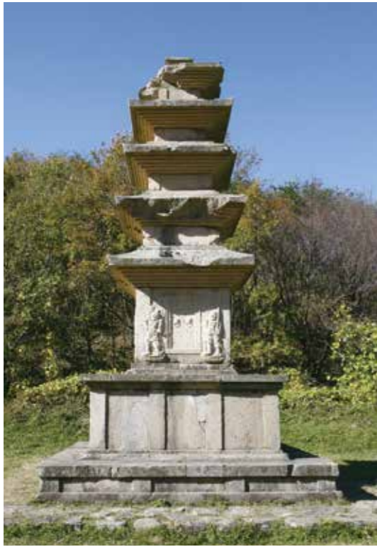
写真37 慶州・獐項里西五重石塔
