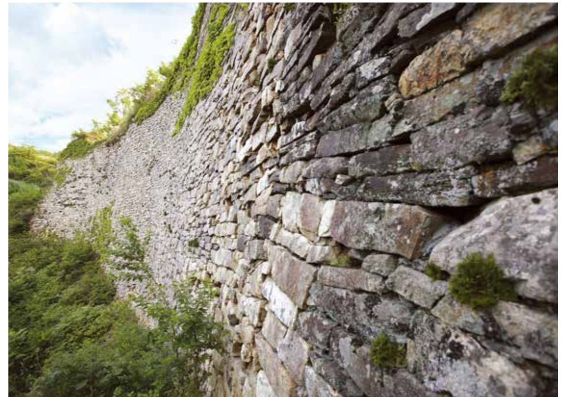
写真3 報恩・三年山城の城壁
